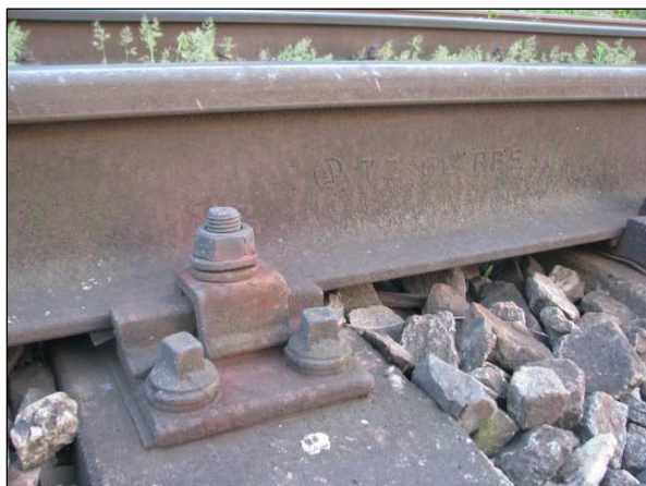
Detail železničního svršku, 2. kolej
