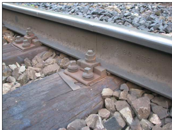
Detail železničního svršku, 1. kolej
