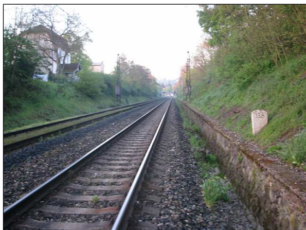
Pohled na trať v místě měření, sm. Beroun
