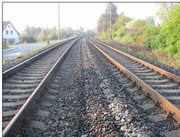
Trať v místě měření
